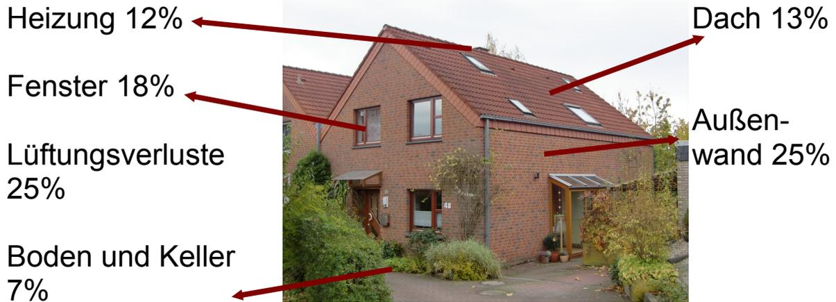
An einem Haus sind die größten Flächen die Außenwände durch die die Wärme verloren gehen kann. Hier gibt es schon lange die Möglichkeit eine Dämmung einzusetzen.
